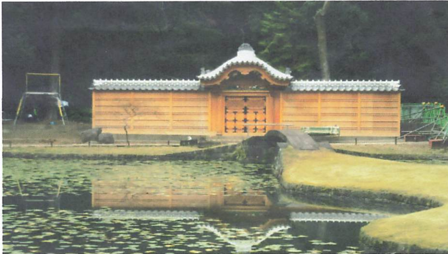
完成時写真 令和2年12月
